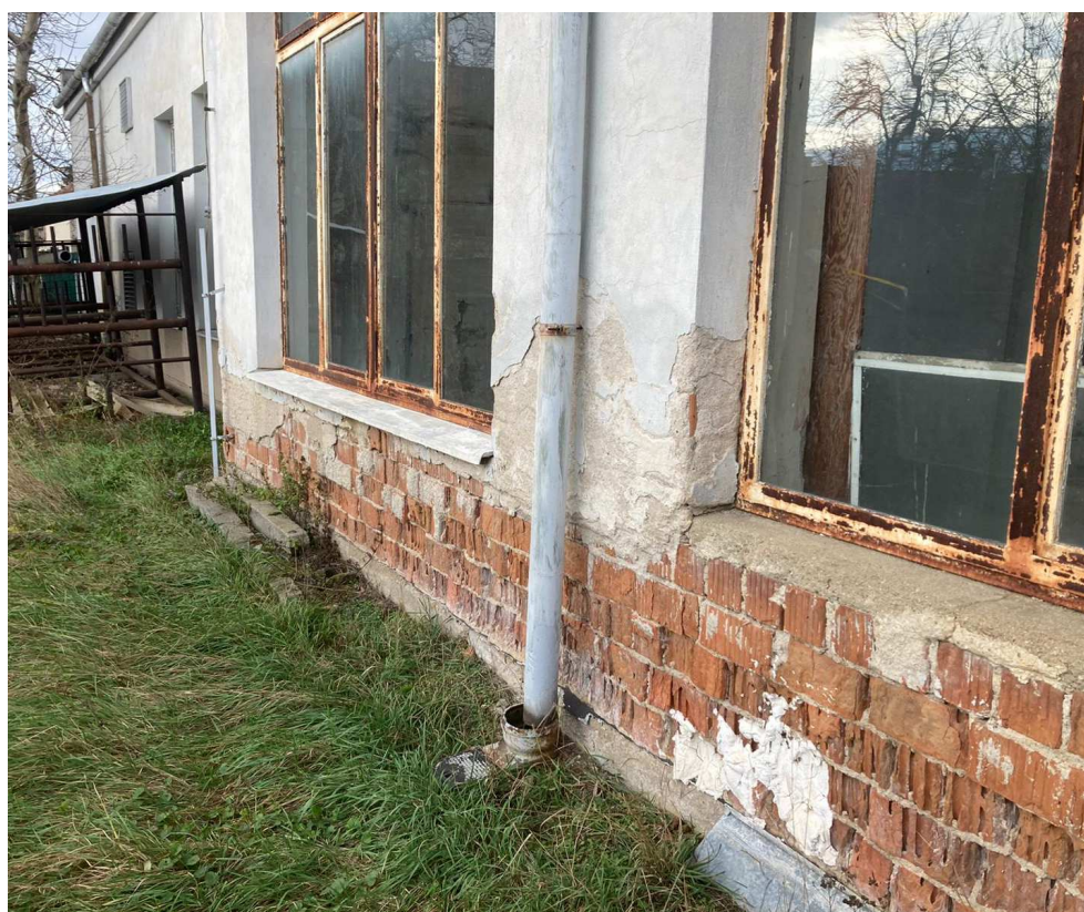
Obr. 22 Opadaná omítka na soklové části objektu
